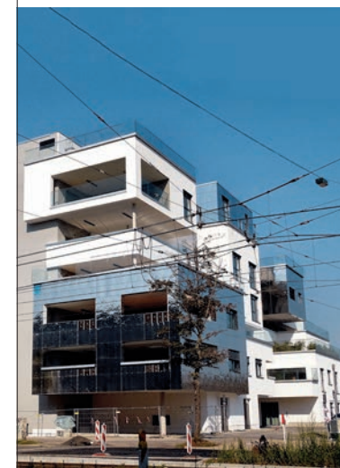
Konversion in cool: In Heerdt wurde ein ehemaliger Luftschutzbunker zum Wohnhaus umgebaut
