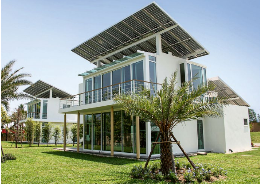
In Thailand kommt AEM-Technologie bereits in einer Wohnanlage zum Einsatz.
