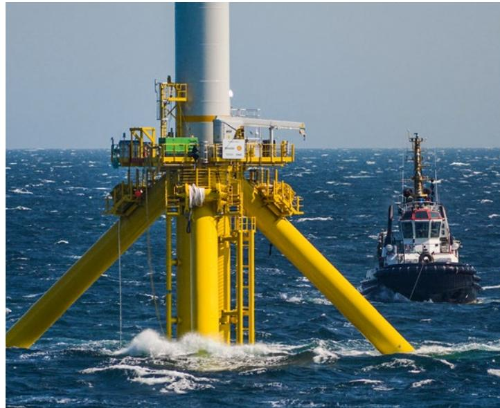
Schwimmende Windkraftplattformen wie das TetraSpar sollen der Offshore-Windkraft zum weltweiten Durchbruch verhelfen.
